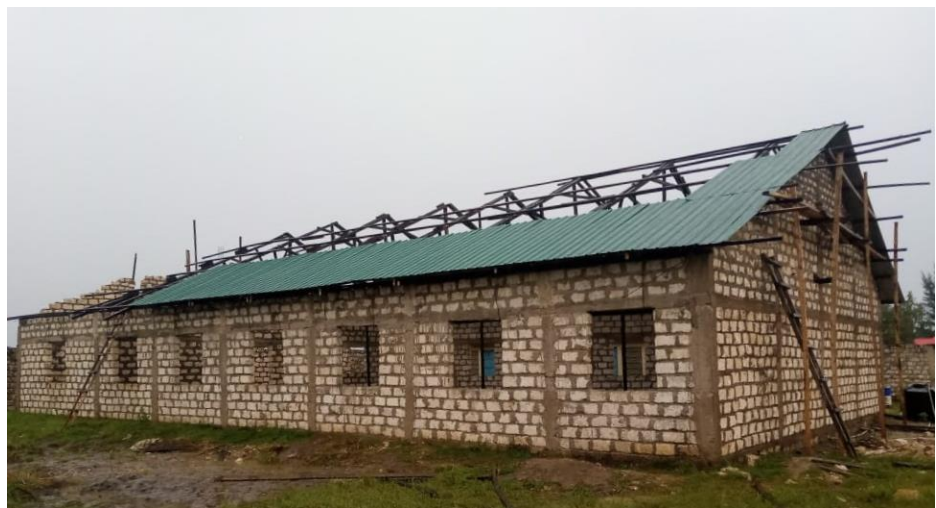
Bouw Restaurant - Keuken
